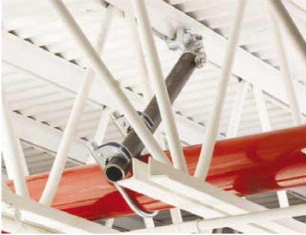
Şekil 7. Enine deprem askısı.
