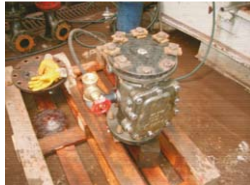
Şekil 7. Hidrostatik dayanım testi.
