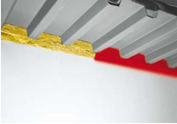
Şekil 7. Kompozit döşeme ve duvarın birleşim noktalarındaki hareketli derzlerin yalıtılmasında kullanılan spray mastik uygulaması.
