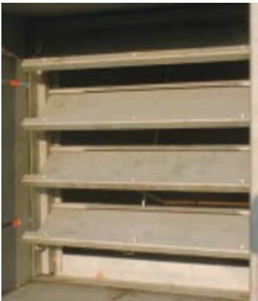
Karşı ağırlıkla çalışan damper.
