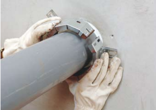
Şekil 3. Plastik borular için kullanılan intümesan sargılı kelepçe uygulaması.
