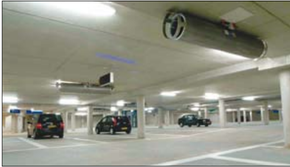
Şekil 3. Jetfan uygulaması[26].
