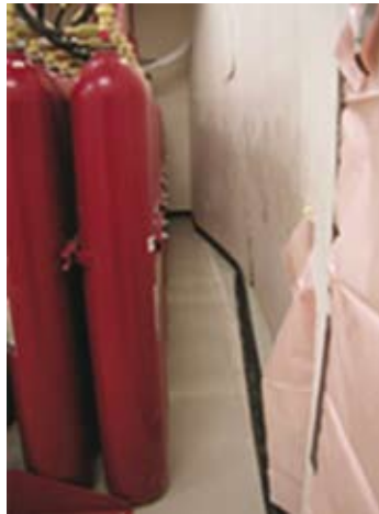
Duvarda oluşan hasar.
