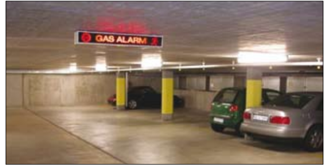
Şekil 4. Yeraltı otoparklarda LPG algılama ve alarm sistemi[27].
