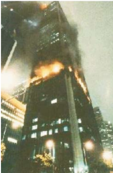
Resim 4.1. 12. katta başlayan yangının dışarıdan görünüşü.
