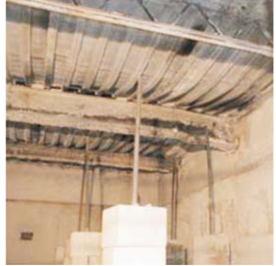
Resim 6.1. UL tarafından ASTME 119 yangın testinden başarı ile geçmiş bir çatı döşemesi
