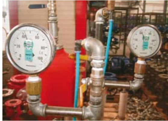
Şekil 9. Trim Tesisatı Testi 2
