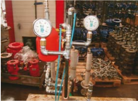
Şekil 8. Trim Tesisatı Testi 1
