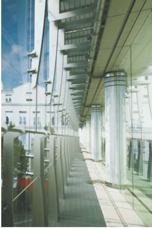
Şekil 4.1. Çift cephe sistemleri www.behance.net
