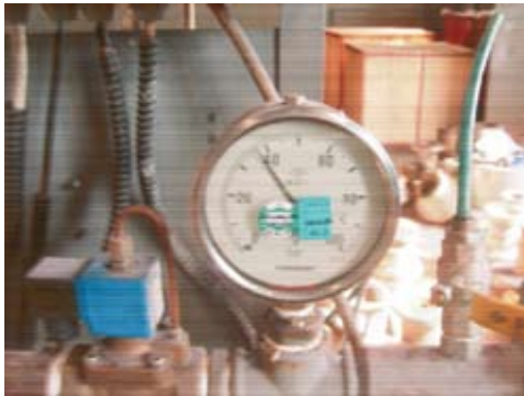
Şekil 5. Sprinkler sızdırmazlık testi.
