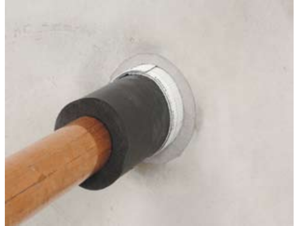
Şekil 4. Yanıcı izolasyonlar için kullanılan intümesan sargı uygulaması.
