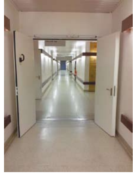
Resim 1. Duman algılamalı yangın bölmesi.
