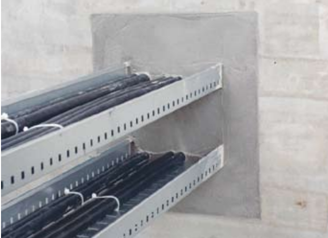
Şekil 5. Elektrik kablolarının ve tavalarının geçişlerinde kullanılan yangın durdurucu harç uygulaması.
