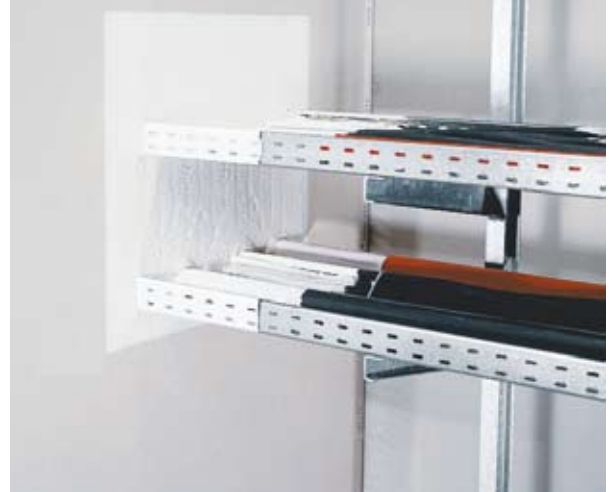
Şekil 6. Elektrik kablolarının ve tavalarının geçişlerinde kullanılan yangın durdurucu taş yünü panel boyası uygulaması.
