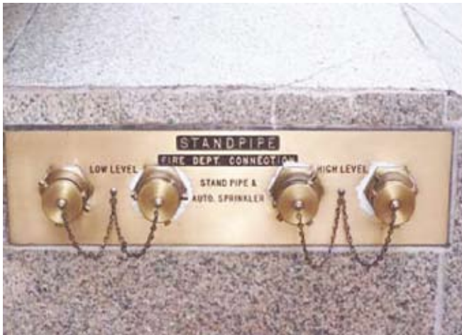
Resim 4. Alçak ve yüksek zon itfaiye bağlantı ağızları.
