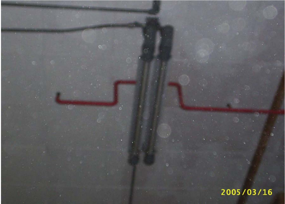
Açıklama : Exproof Aydınlatma Armatürü
